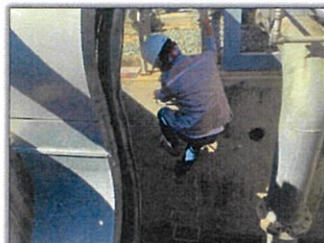
PO1 แจ้ง CRO ตรวจวัด LEL = 5% จะเริ่มทำการขันอัด Valve PO1 แจ้ง Valve ทักขณะขันอัด ทำให้เกิดการรั่วไหลของ NG
