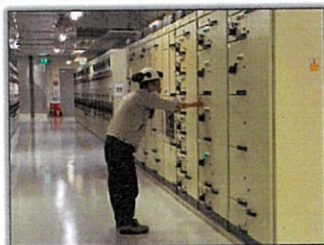
ESM ตรวจสอบ Breaker CT Makeup Water Pump No.3 ที่ระเบิด
