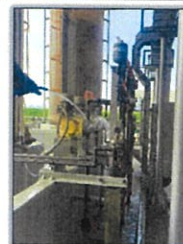
PO2 ใช้น้ำล้าง Valve และ Pump และ ไล่ล้างสารเคมีออกจาก Bund
