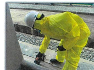
PO2 เปิด Bund Valve เพื่อระบายน้ำชะล้างและสารเคมีที่รั่วไหลลง Neutralization Pit
