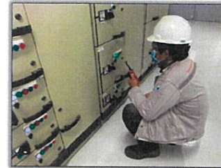
PO แจ้ง CCR On Breaker CT Makeup Water Pump No.3 หลังการซ้อมบํารุง
