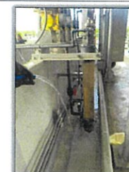
PO2 ใช้น้ำล้าง Valve และ Pump และ ไล่ล้างสารเคมีออกจาก Bund
